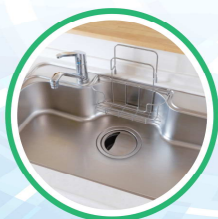
キッチンの排水管
