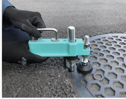
クサビの取り付け位置に注意して 本体を組み込む
