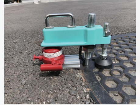
油圧ジャッキを組み込む
